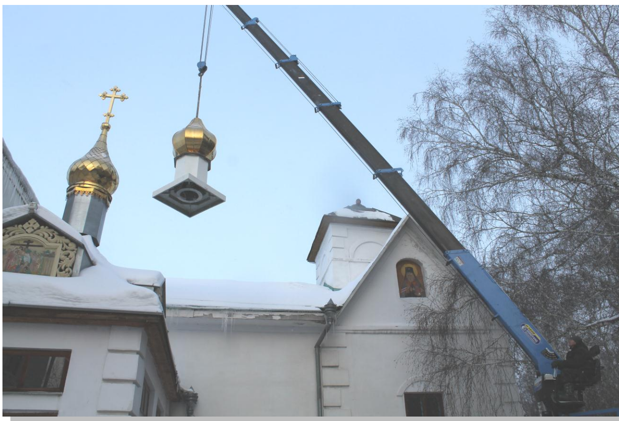
Установление купола на приделе в честь Священномученика Сильвестра Омского
