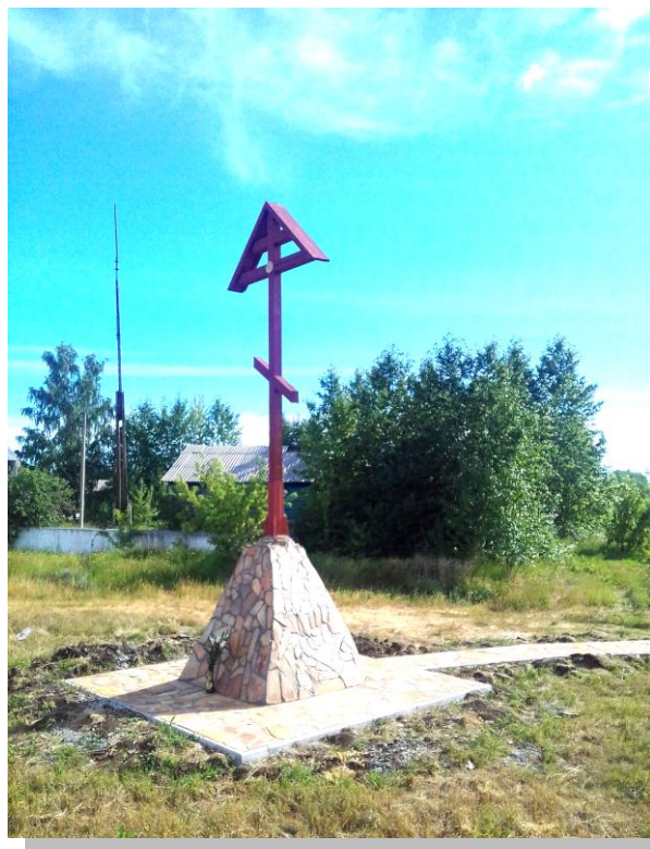
Поклонный крест после ремонта основания в 2017 г.
