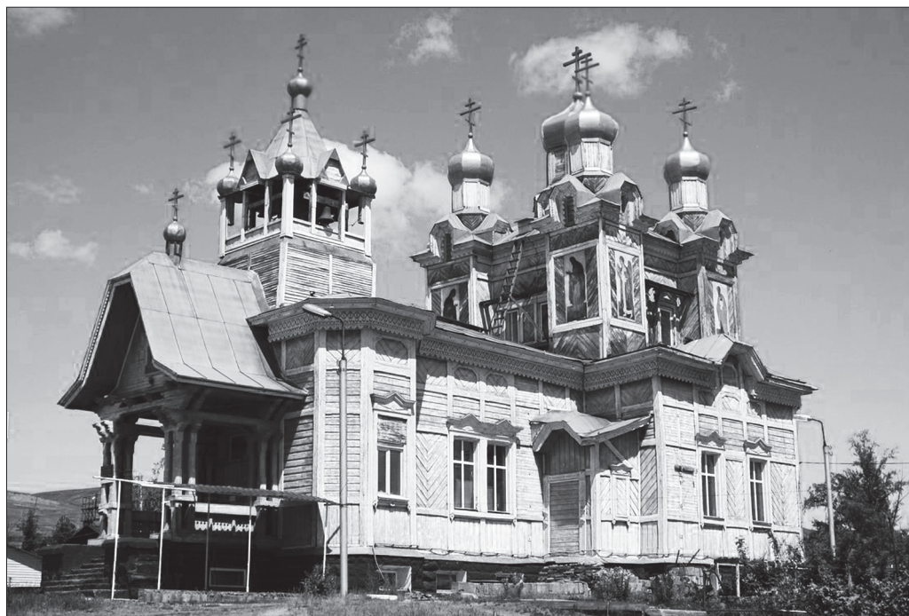
Петро-Павловская церковь, ст. Шилка
